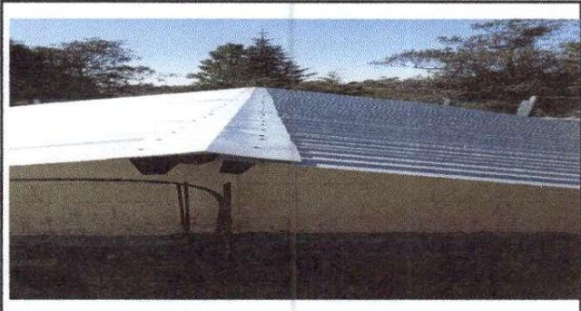
Foto 2: sustitución de Capote de lámina para lamina troquelada
