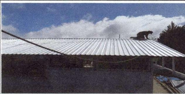
Foto 3: Sustitución de Elementos de fijación
