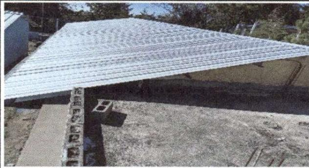
Foto1: Sustitución de Lamina, por lamina troquelada alucinc calibre 26
