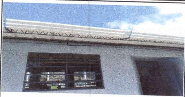
Foto 8: Sustitución de Canal de Metal
