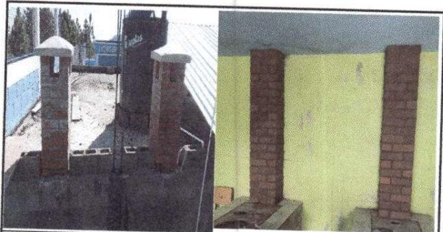
Foto 12: Sustitución de Chimeneas
